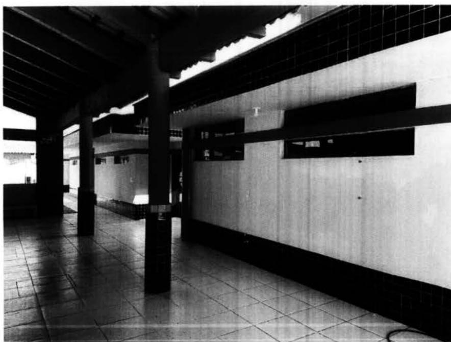
*Imagem 6 – Pintura interna, substituição de revestimento cerâmico 10x10 nas paredes internas das salas e substituição de piso cerâmicos danificados.*
