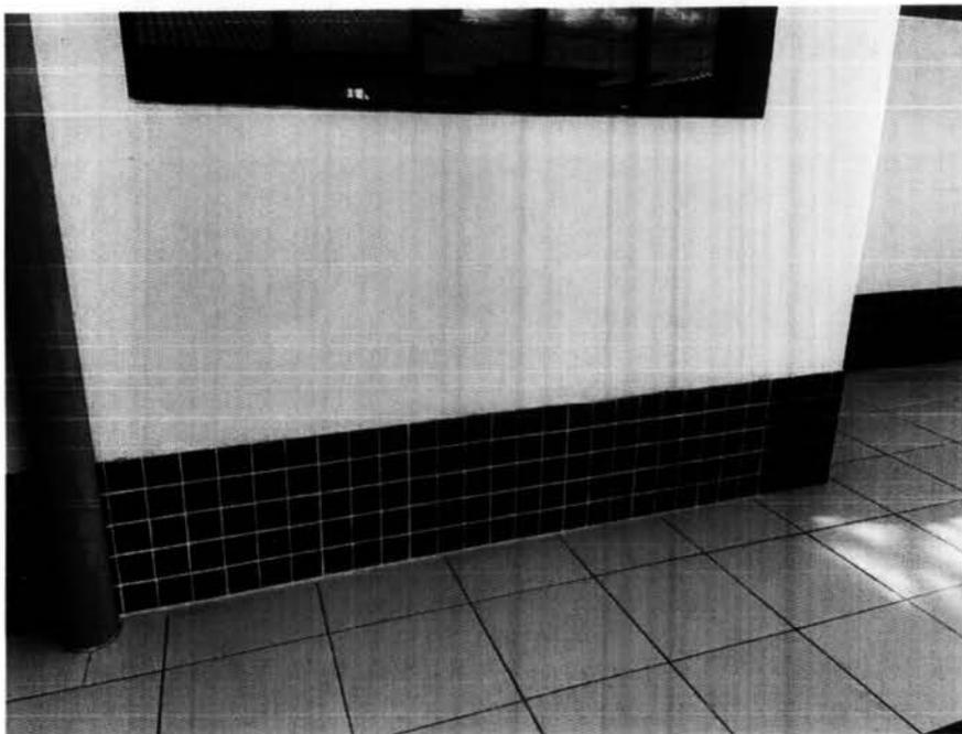
Imagem 9 – Pintura interna, substituição de revestimento cerâmico 10x10 nas paredes internas das salas e substituição de piso cerâmicos danificados.
