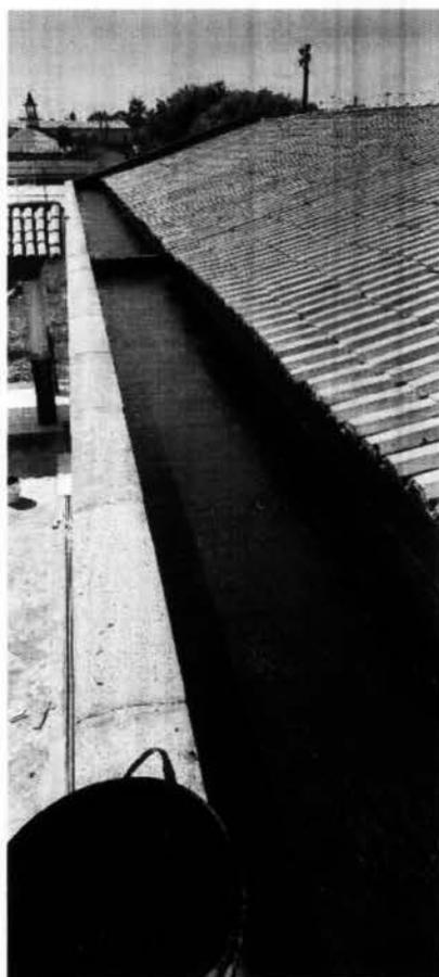
*Imagem 12 – Retelhamento, instalação do rufo metálico e aplicação do impermeabilizante na calha de concreto.*
