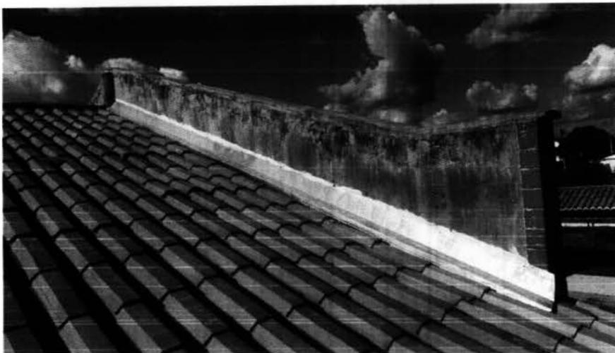
*Imagem 11 – Retelhamento e instalação do rufo metálico.*
