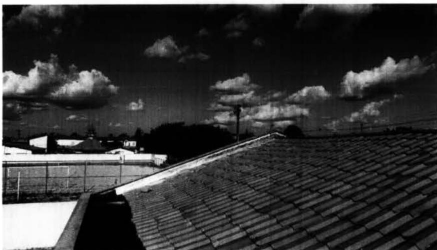
Imagem 10 – Retelhamento, instalação do rufo metálico e aplicação do impermeabilizante na calha de concreto.
